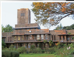
東京都選定歴史的建造物である「浴風会本館」。関東大震災の被災老人を援護する施設として、大正15年に建てられた。
