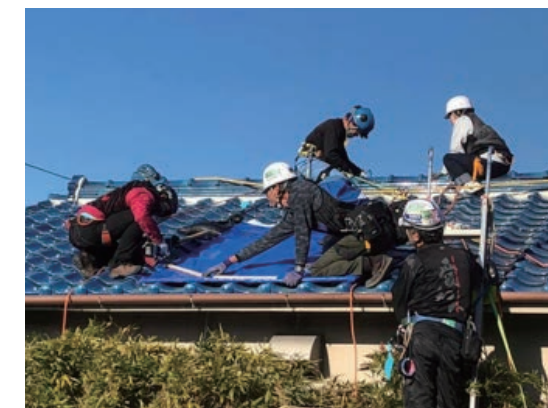
大阪府北部地震被災地での活動のようす(大阪府) 家屋の雨漏りを防ぐ応急処置としてブルーシート張りを行いました。
