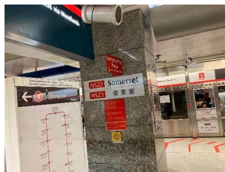
写真 1 シンガポール MRT 南北線サマセット駅構内
