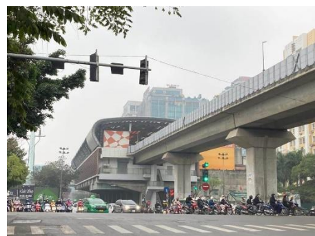
写真 2 ハノイ・メトロ 2A 号線ラティン駅外観
